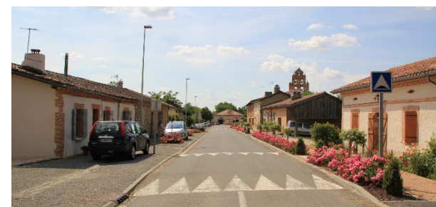
Figure 73 : RD 160 après l'aménagement des espaces publics
