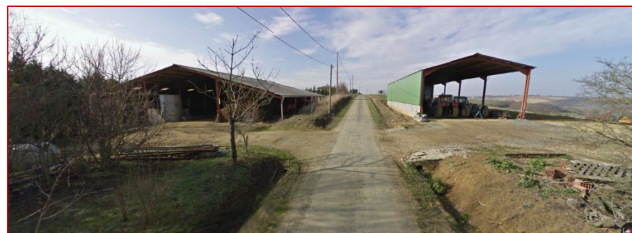
Figure 29 : hangars agricoles chemin rural n°8, source Google
